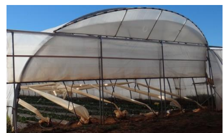
Aération tunnel – Photo CA30
