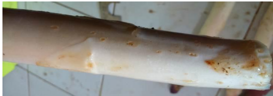
Dégâts de myriapodes - Photo SUDEXPE
