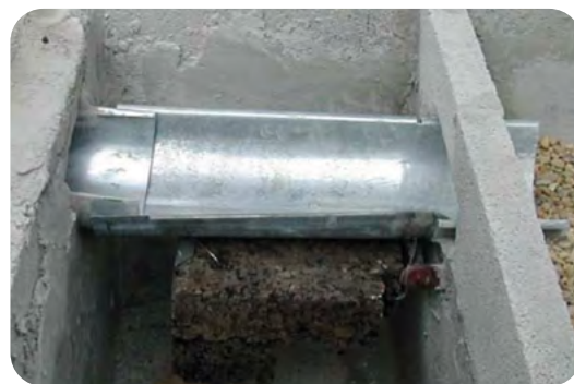
Figure 4 : Disconnecteur en position fermé vers le filtre à granulats
