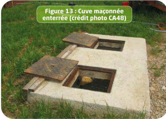
Figure 13 : Cuve maçonnée enterrée (crédit photo CA48)
