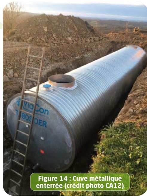
Figure 14 : Cuve métallique enterrée (crédit photo CA12)
