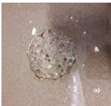
Photos 2 et 3 : altération de la résine au sol et aux plinthes
