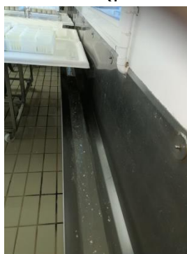
Photos 9 et 10 : dispositifs pour l'évacuation du petit lait
