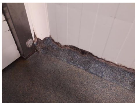
Photos 2 et 3 : altération de la résine au sol et aux plinthes
